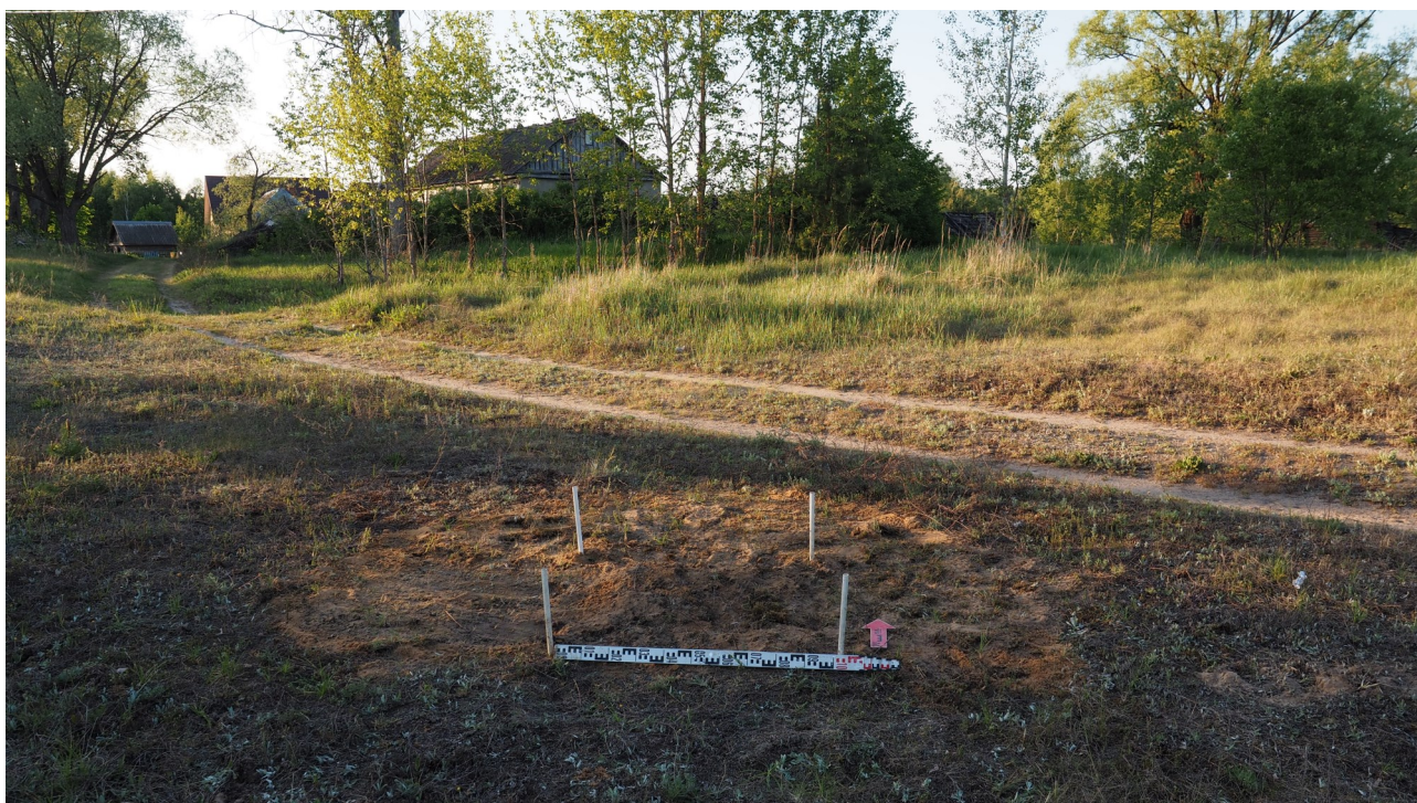
Рис. 48. Калужская область, Думиничский район. 2023 г. Археологическое обследование по объекту: «Уличные газопроводы дер. Ясенок». Шурф 4 после засыпки. Вид с юга.
