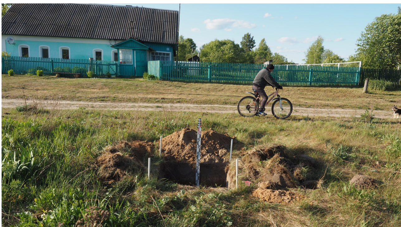
Рис. 38. Калужская область, Думиничский район. 2023 г. Археологическое обследование по объекту: «Уличные газопроводы дер. Ясенок». Вид на раскопанный шурф 2 с юга.
